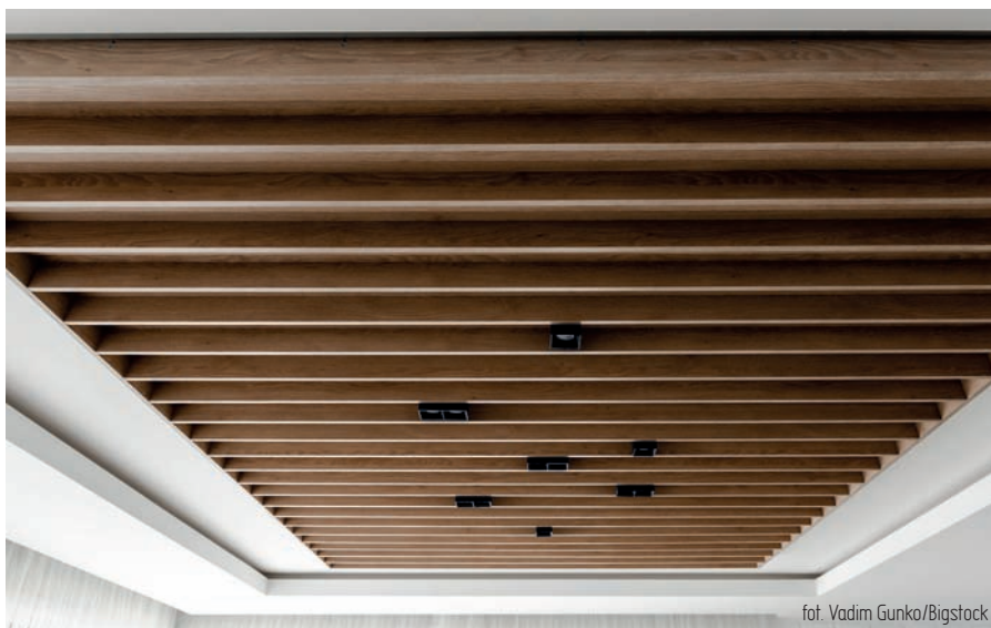
Rys. 14. Przykład zastosowania sufitu z panelami pionowymi (mikroperforowany fornir z wypełnieniem pochłaniającym dźwięk)
