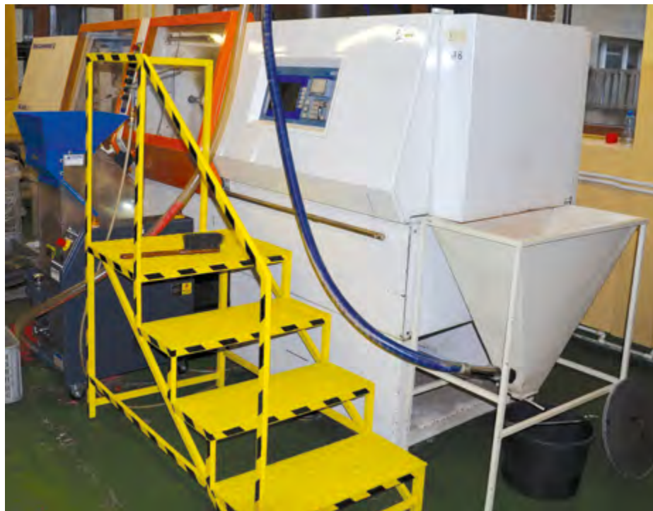
Rys. 74-1. Podest o barwie kontrastowej względem otoczenia wraz z oznakowaniem krawędzi stopni schodów ukośnymi pasami żółto-czarnymi
