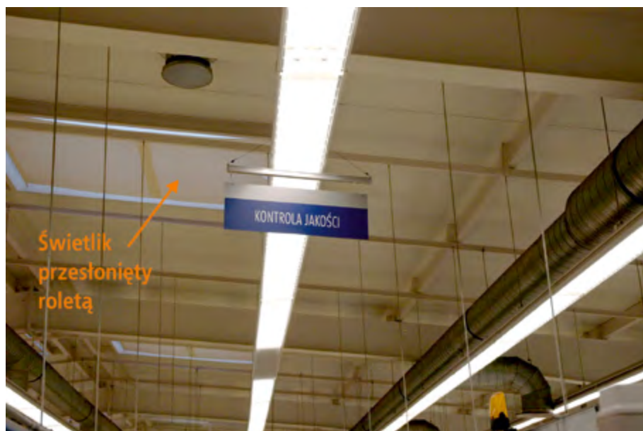
Rys. 30-1. Światliki przesłonięte roletami w dachu pomieszczenia przemysłowego
