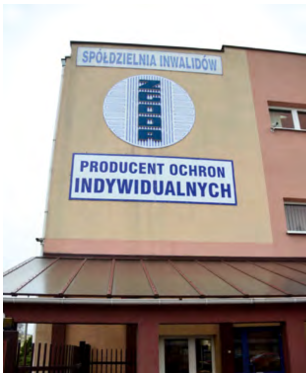
Rys. 9-1. Duże i kontrastowe znaki z nazwą zakładu (a) oraz duże i kontrastowe tablice z nazwą zakładu (b), umieszczone na elewacji budynku
