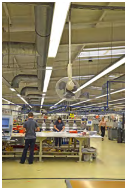
Rys. 78-3. Podwieszany wentylator w hali produkcyjnej
