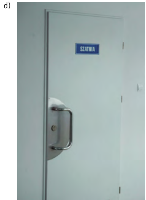
Rys. 24-1. Kontrastowe zróżnicowanie klamki (a) lub obszaru klamki (b, c, d) na drzwiach
