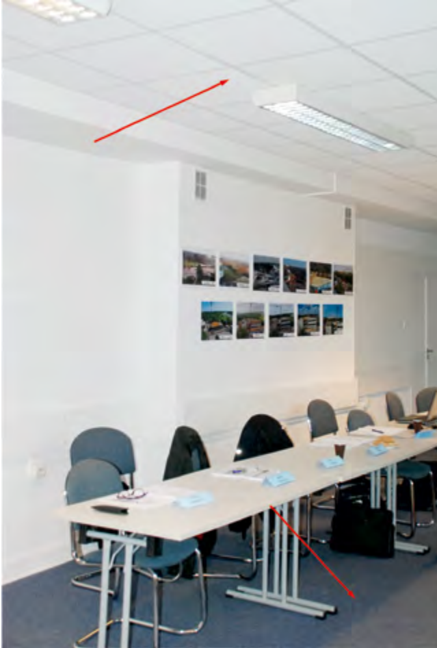
Rys. 43-1. Adaptacja akustyczna w pomieszczeniu pracy biurowej (podwieszany sufit z panelami dźwiękochłonnymi o wysokim współczynniku pochłaniania dźwięku oraz gruba wykładzina dywanowa)
