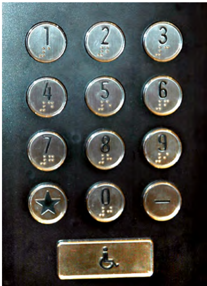
Rys. 7-1. Duże i kontrastowe oznaczenia na przyciskach tablicy w kabinie dźwigu osobowego
