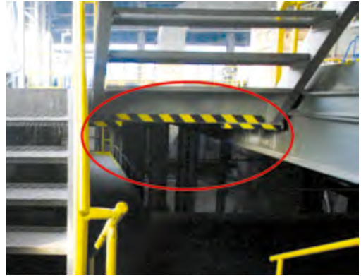
Rys. 76-1. Oznakowane (żółto-czarnymi ukośnymi pasami) elementy obniżające wysokość przejścia (a, b, c, d); miejsca stwarzające zagrożenie urazem głowy oznakowane dodatkowo znakami ostrzegawczymi: niebezpieczeństwo uszkodzenia głowy (a) i ograniczenie wysokości przejścia do wysokości 1,8 m (b)
