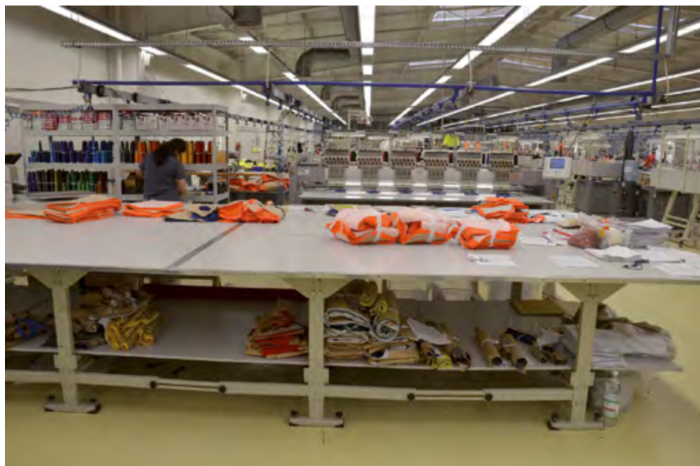
Rys. 29-1. Bezołśnieniowe oprawy oświetlenia ogólnego z możliwością załączania poszczególnych sekcji
