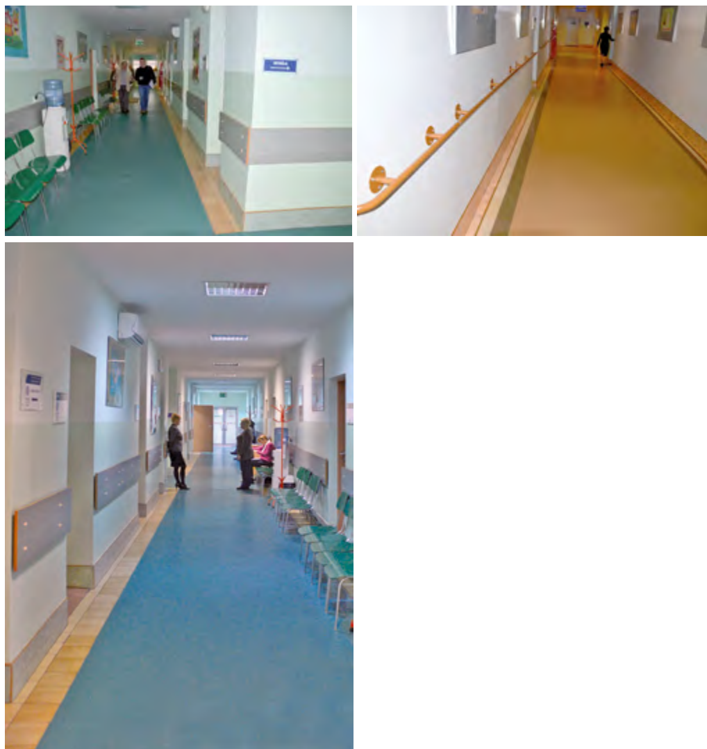
Rys. 19-1. Zróżnicowanie barwy wykładziny podłogowej na korytarzach na poszczególnych piętrach budynku
