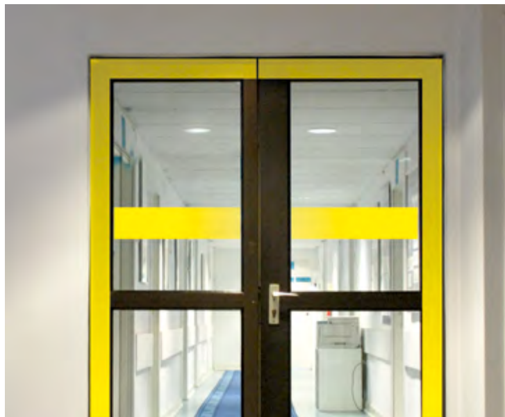
Rys. 15-1. Oznakowanie szklanych drzwi oraz ich ościeżnic za pomocą kontrastowych pasów o barwie żółtej
