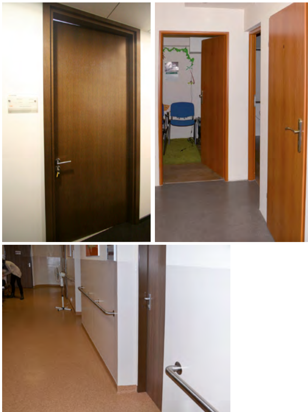
Rys. 20-1. Drzwi wraz z futryną o barwie kontrastowej względem ściany
