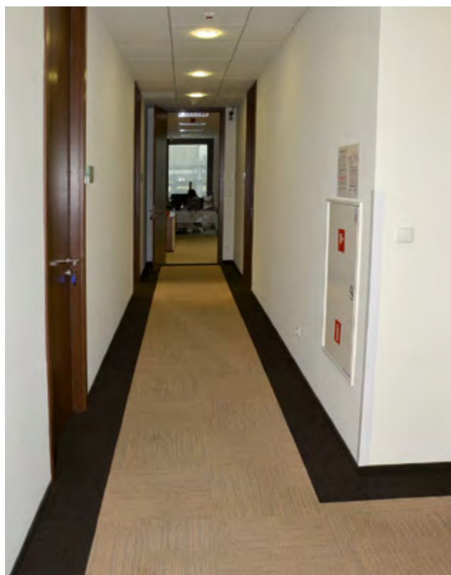
Rys. 17-1. Kontrastowe różnicowanie ścian i podłogi na korytarzu za pomocą kontrastowego pasa na podłodze
