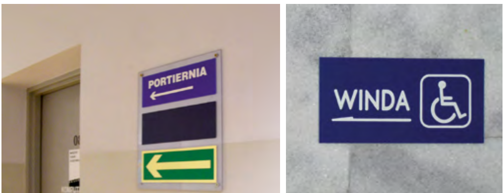
Rys. 10-2. Znaki informacyjne wskazujące kierunek, wykonane dużymi literami o kontrastowej barwie względem tła
