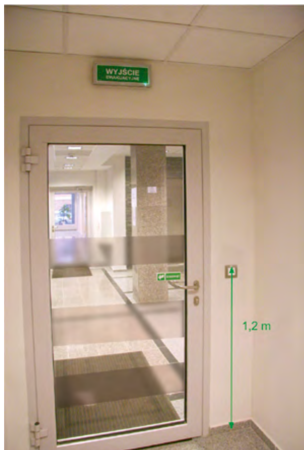
Rys. 3-1. Osprzęt elektryczny zamontowany na odpowiedniej wysokości
